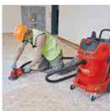
szlifowanie betonu
