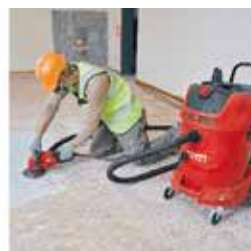
szlifowanie betonu
