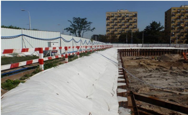
Rys. 3. Zabezpieczenie powierzchniowe skarpy przed rozmyciem
