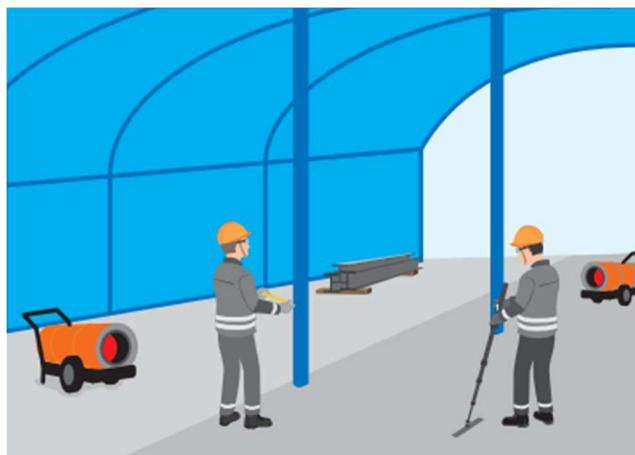
Rysunek 2 Wykonywanie prac pod ciepłakiem
