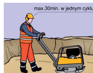
Rys. 1. Zagęszczanie gruntu ubijakami mechanicznymi
