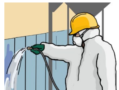
Рис. 3. Увлажнение асбестосодержащих материалов
