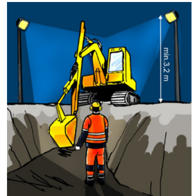
Рис. 5. Освещение строительной площадки
