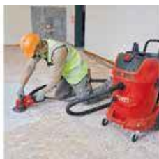
szlifowanie betonu
